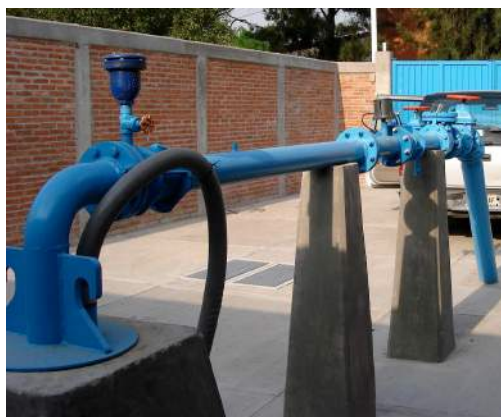
Trenes de descarga de pozos de agua
