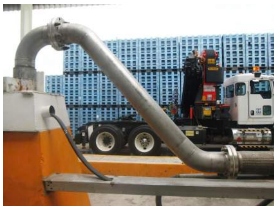
Trenes de descarga de pozos de agua
